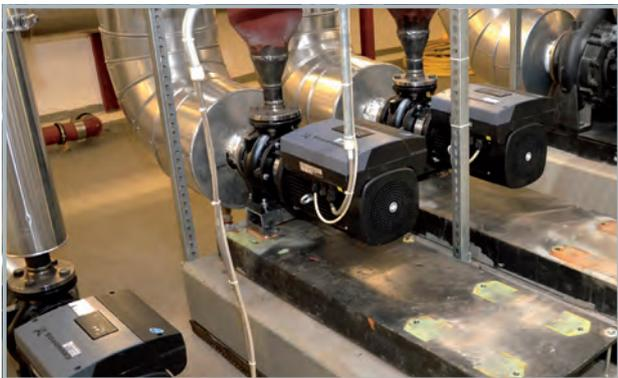
Die neue Anlage mit drei identischen Blockpumpen NBE 50-125/121, von denen zwei mit 20-prozentiger Leistungsreserve die Spitzenlast abdecken
