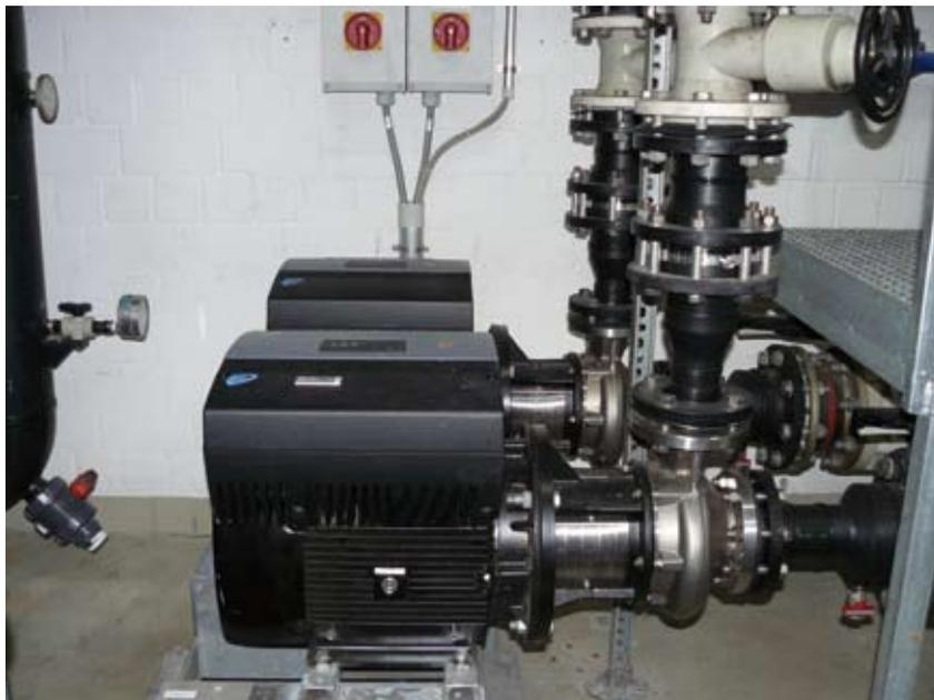
Statt der zuvor installierten 37-kW-Aggregate reichen diese beiden 15-kW-NBE-Pumpen für die geforderte Kühlwasserversorgung vollkommen aus, wie das ‚Pump Audit‘ des Grundfos-Service zeigte.
