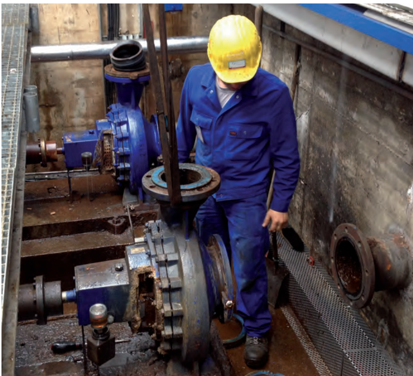
Demontage der Altanlage: Dirk Ahlvers, Techniker von Pumpen Binek
