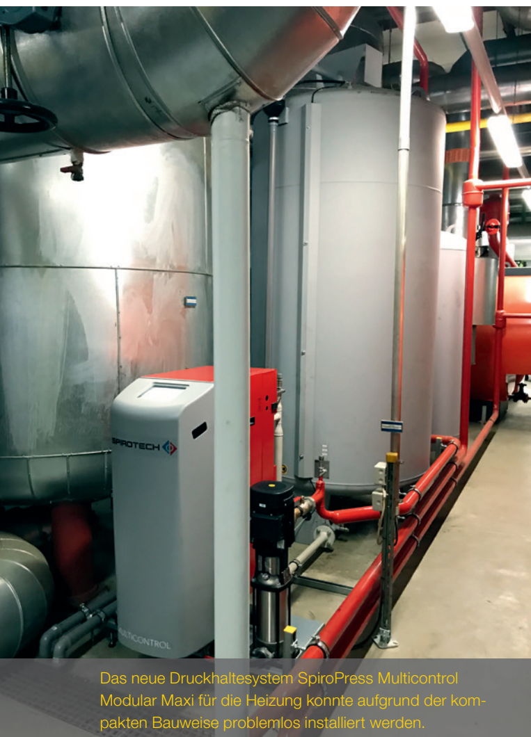
Die Ausführung Maxi verfügt über zwei Pumpen, die jeweils eine 100-prozentige Leistung aufweisen.
