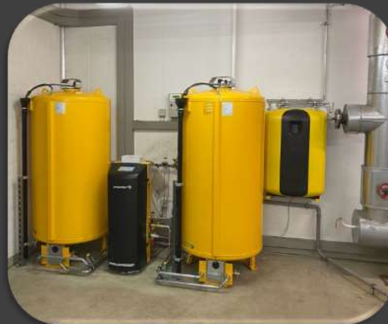
Neue Druckhaltung mit Entgasung und Abscheidern
