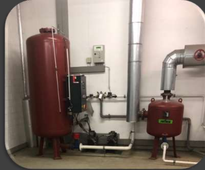
Alte Druckhaltung ohne Entgasung mit Schmutzfängern
