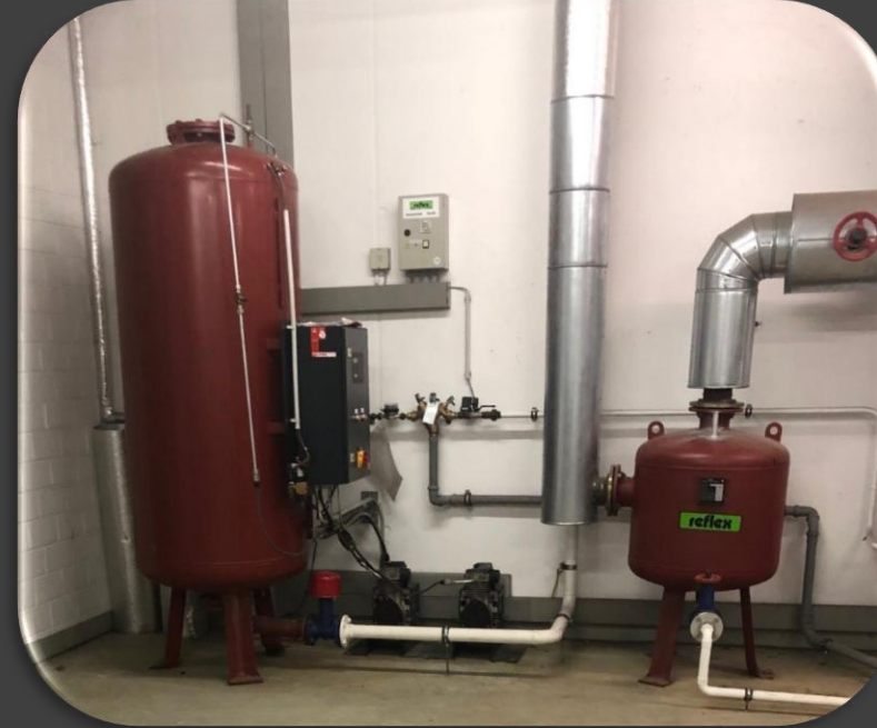
Alte Druckhaltung ohne Entgasung mit Schmutzfängern
