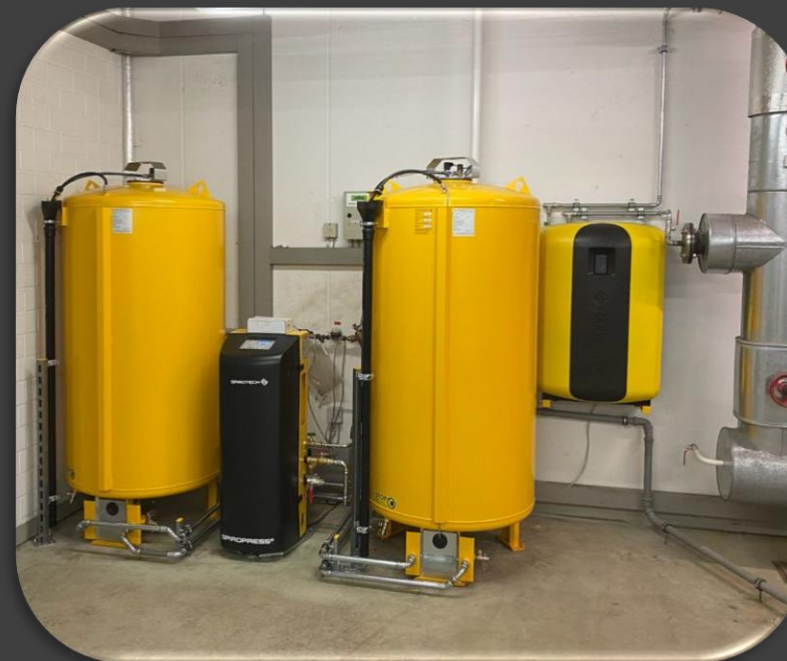
Neue Druckhaltung mit Entgasung und Abscheiden
