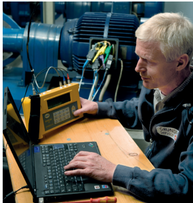
20-50 % der von Pumpen verbrauchten Elektroenergie könnten durch Optimierung eingespart werden
